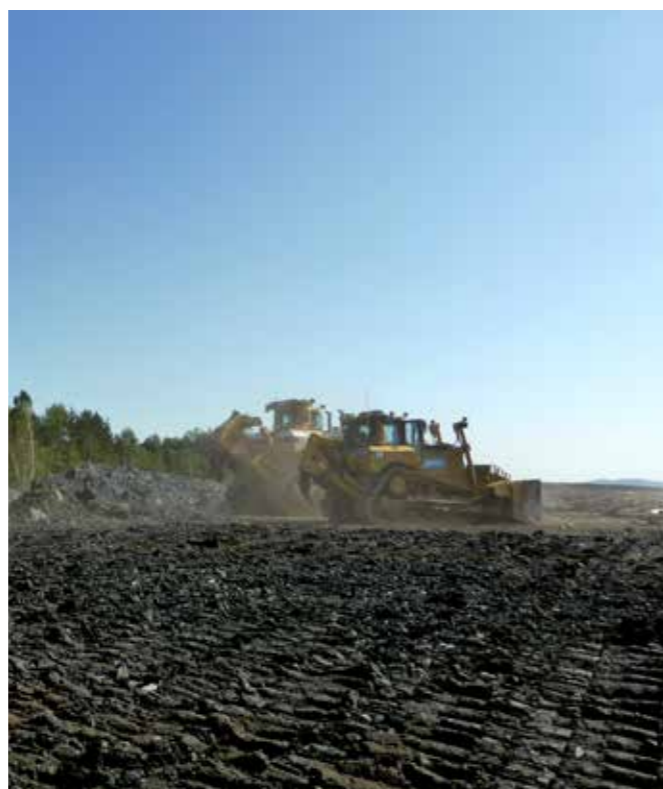
Testfelt på NOAH Langøya: Utlegging og komprimering av KS-leire. Foto: NOAH AS
