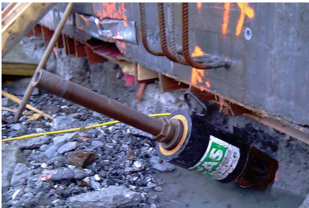
Figur 27: Strekktesting av injeksjonsstag
