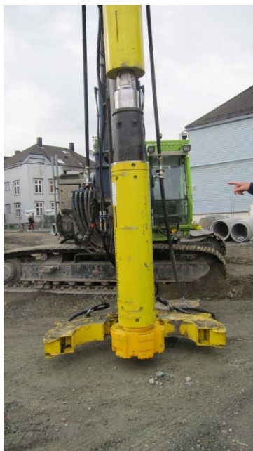
Figur 6 Senkhammer med pilot for rørboring nede og overgang til borerør oppe.
