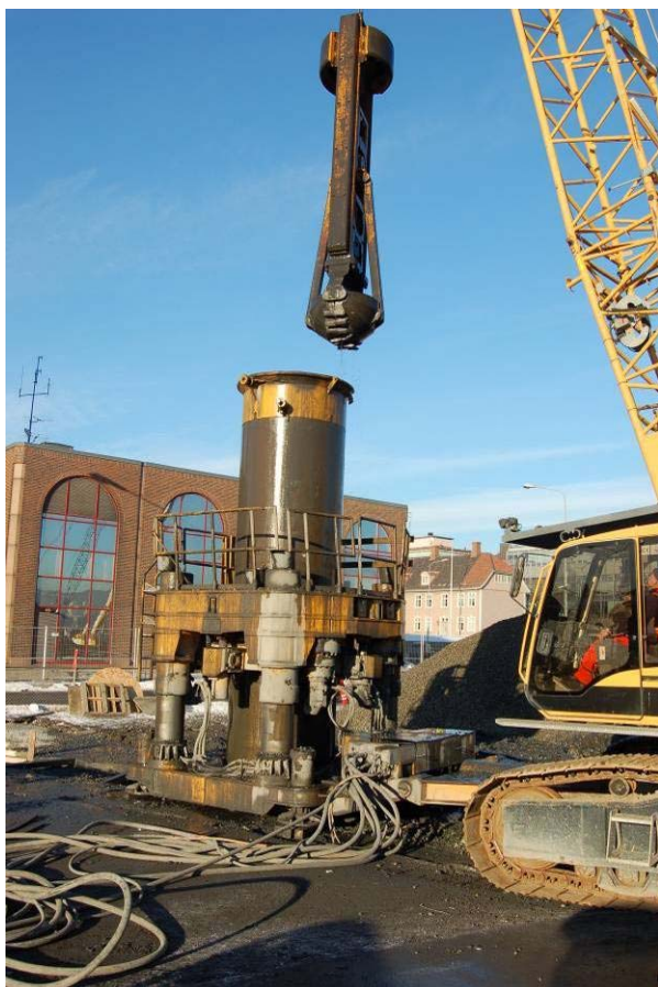
Figur 48: Eksempel sjaktning med grabb
