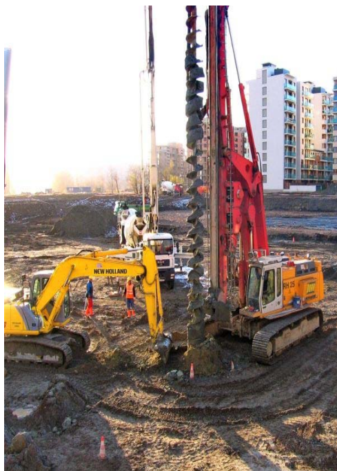
Figur 50: Eksempel auger rigg
