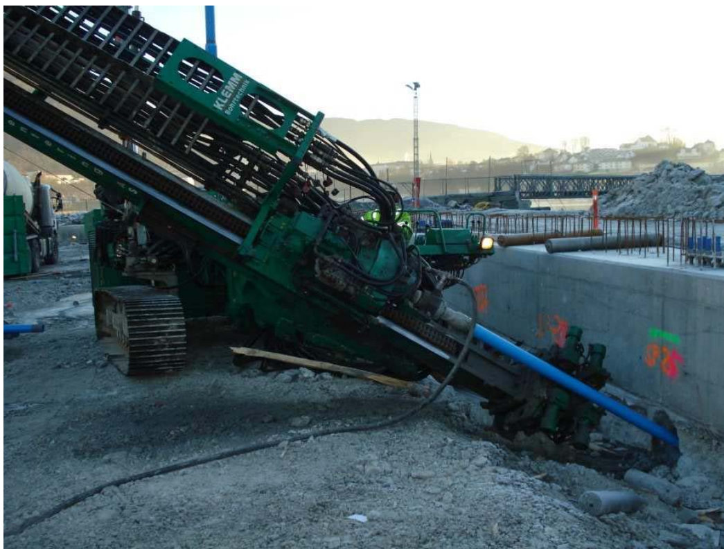
Figur 28: Fjellforankring på Helleren i Bergen
