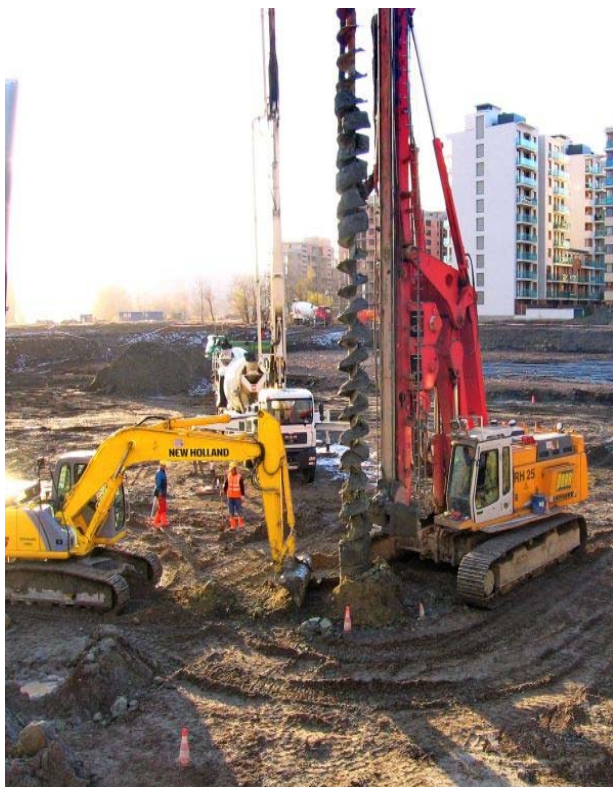
Figur 50: Eksempel auger rigg
