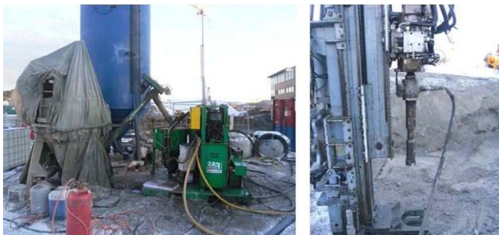
Figur 26: Til høyre vises deler av rigg med hydraulisk topphammer og tilkoblet injeksjonslange. Til venstre vises eksternt blandeverk, samt betongblander og pumpe.
