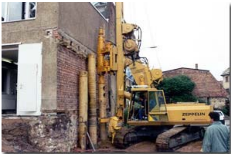
Figur 51: Eksempel på CFA med foringsrør
