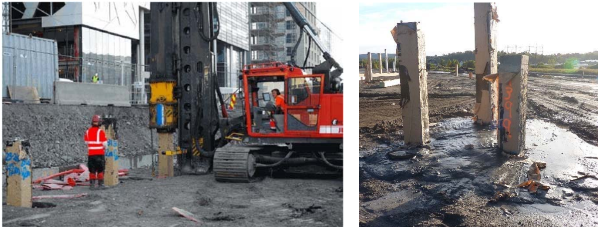
Figur 3-11. Ramming av betongpeler ved Dronning Eufemias gate (Bilde: Geovita) til venstre og massefortrengning sensitiv leire ved ramming av peler ved Bama, Alfaset til høyre (Bilde: NGI).
